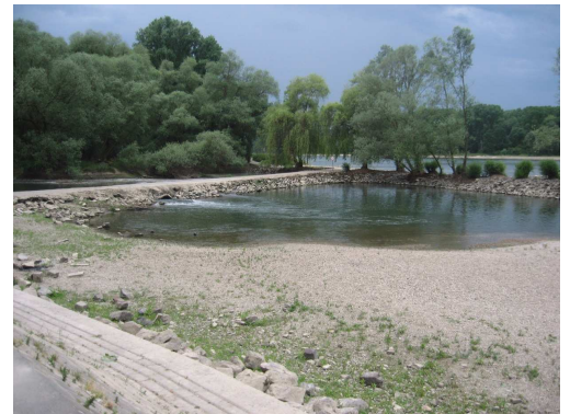
Belle bei Niedrigwasser
