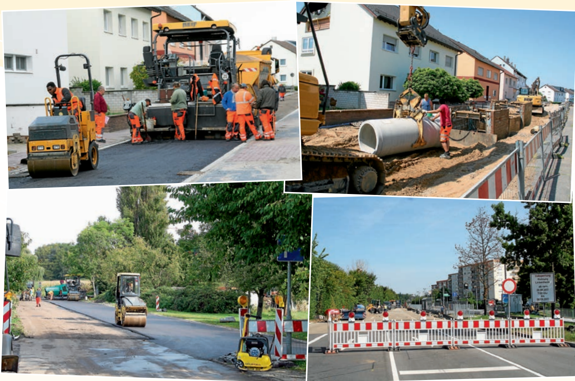
Straßen- und Gehwegsanierung: Der erste Teil der Schillerstraße wurde umfassend saniert, Kanalisation, Wasserleitungen, Grundstücksanschlüsse für Wasser und Abwasser sowie Fahrbahn und Gehwege erneuert. Der Ehrlichweg und die alte B36 wurden neu asphaltiert.
