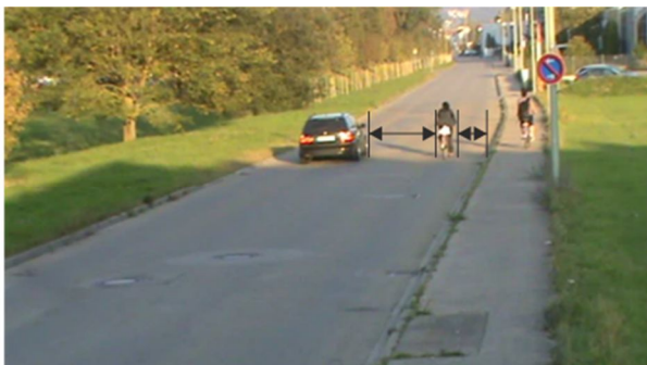
Abb. 33: Schmale Fahrbahnquerschnitte (< 6,50 m) führen zu großen Überholabständen (Steinheimer Straße, Heidenheim), breitere Querschnitte (> 6,50 m) und Leitlinien fördern kritische Überholabstände (Wollhausstraße, Heilbronn)
