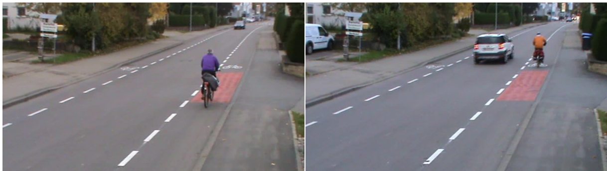
Abb. 36: Schutzstreifen werden mittig befahren, wenn sie ausreichend dimensioniert sind (links). Die Reaktion auf die Beeinflussung durch den Kfz-Verkehr ist bei Schutzstreifen weniger ausgeprägt, d.h. das Abstandverhalten entwickelt sich positiv (rechts).
