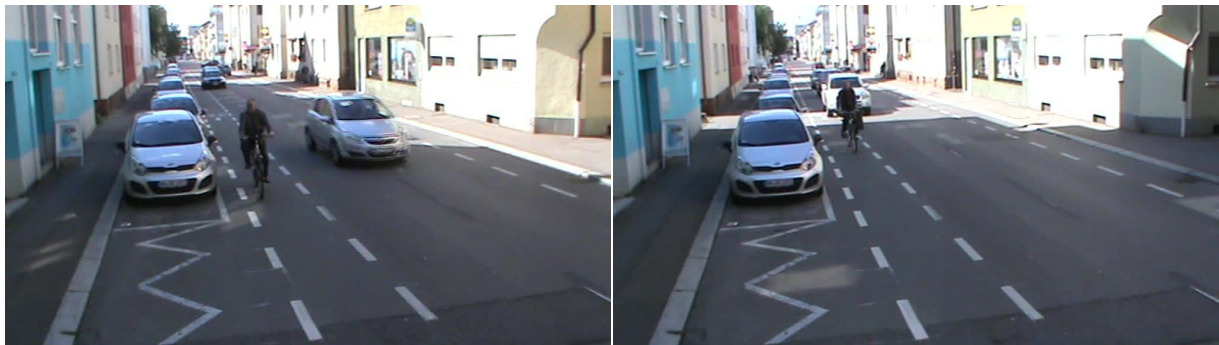
Abb. 35: Bei beidseitigen Schutzstreifen erhöhen sich die Überholabstände, da sich nicht mehr an der Leitlinie orientiert werden kann (links). Bei Gegenverkehr wird selten überholt, der Kfz-Fahrer bleibt hinter dem Radfahrer (rechts)
