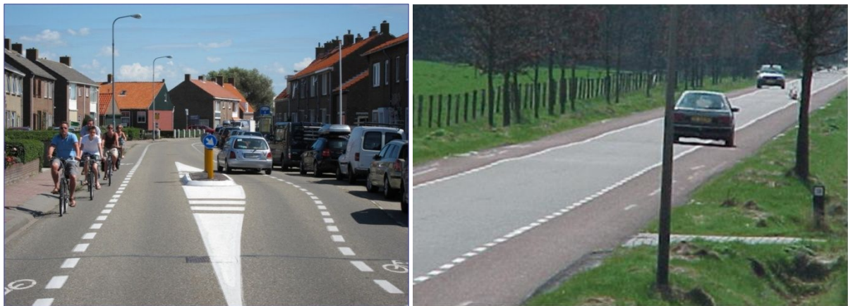
Abb. 6: Schutzstreifen (Suggestiestrook) in den Niederlanden werden auf schmalen Fahrbahnen unter 7,00 m sowohl innerorts als auch außerorts markiert. Eine Mindestkernfahrbahnbreite ist nicht vorgeschrieben.
